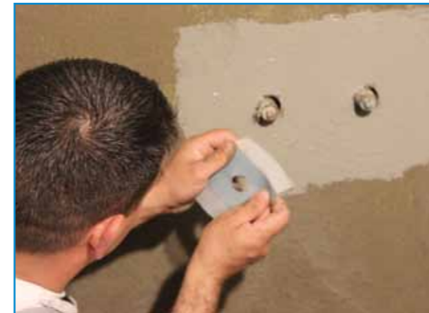
Csőáttörés - vízszigetelő anyagba ágyazott mandzsetta
