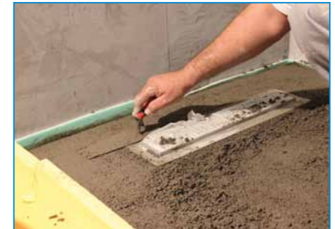
Zuhanyfolyóka körüli lejtés kialakítása
