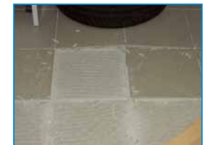
Mozgási hézag nélküli burkolat
