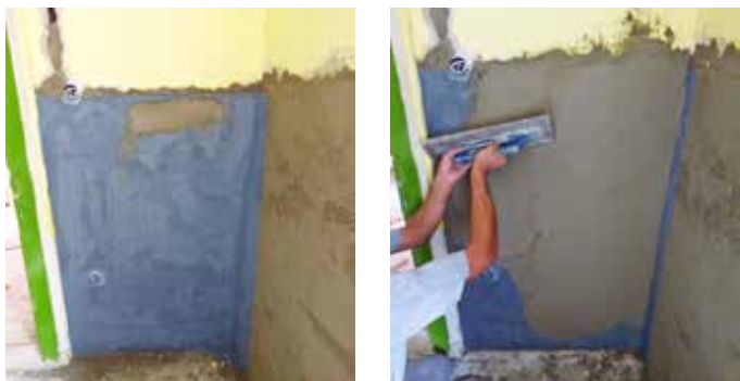
Vályogfal szakszerű helyreállítása Cemix HP Leicht A könnyített alapvakolattal
