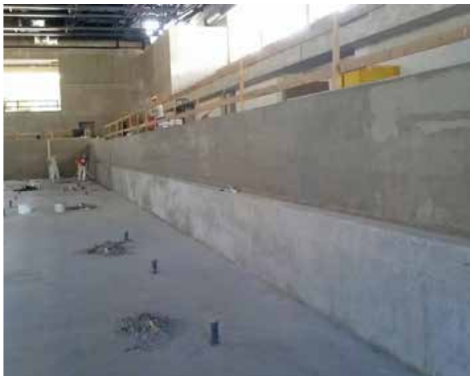
Olimpiai méretű úszómedence építése Cemix Rendo medencefal kiegyenlítő vakolattal
