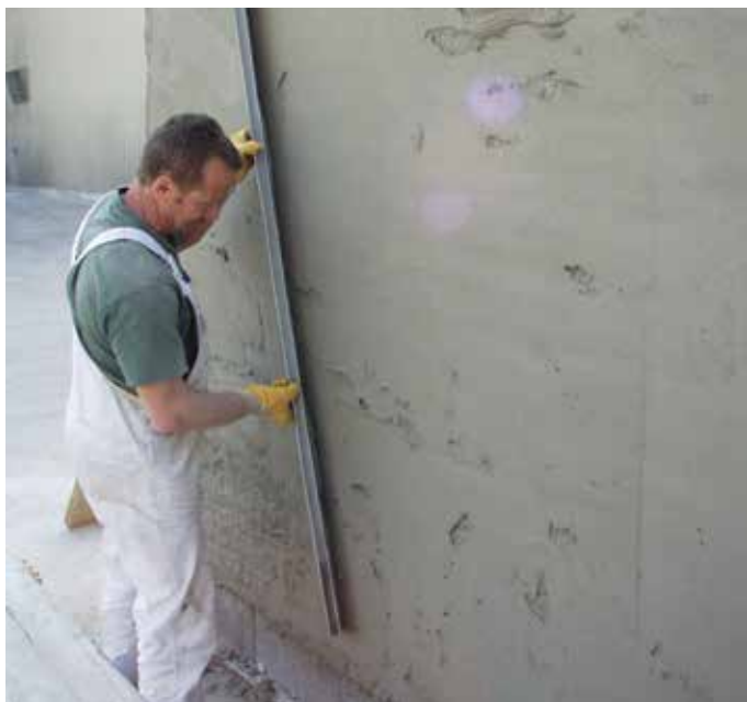
Cemix MP5011 alapvakolat kiegyenlítése
