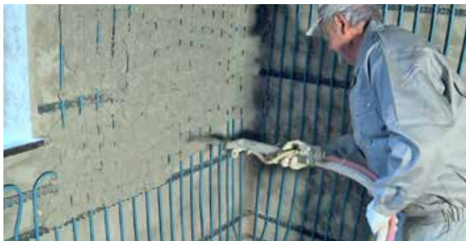
Cemix ThermoWand falfűtésvakolat gépi felhordása
