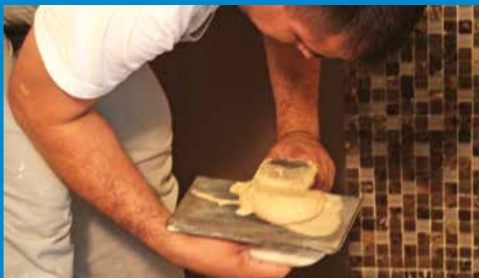
A fugázóanyagot speciális fugázó simítóval juttatjuk a fugákba.
