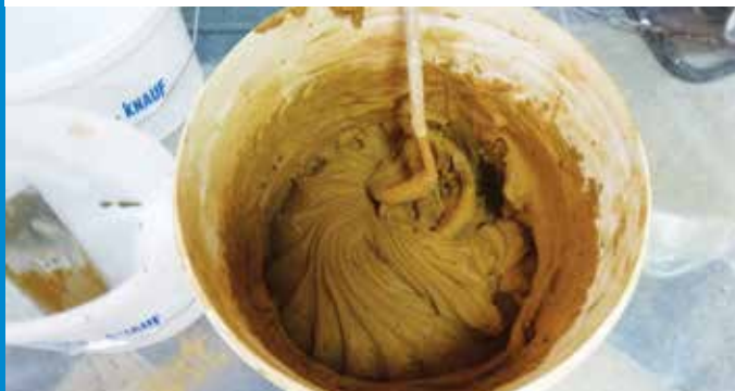
A fugázóanyagot a pontosan kimért víz hozzáadásával csomómentesre keverjük.
