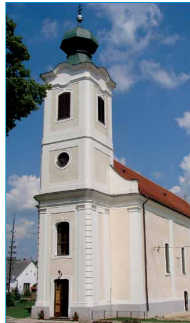
Városlőd, Római katolikus templom - főhomlokzat felújítás után
