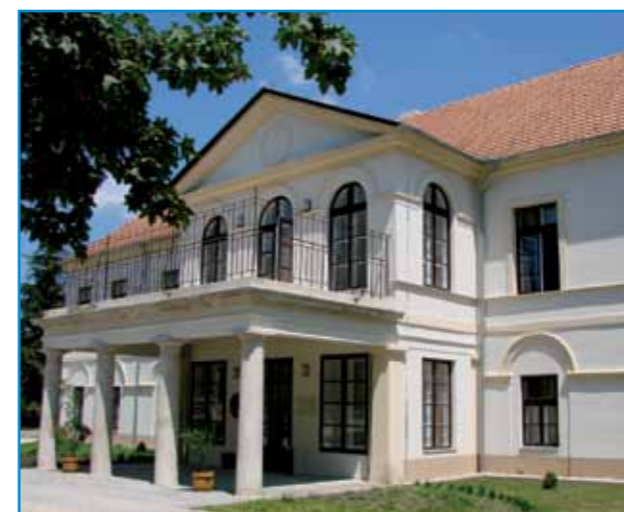
Dáka, Szociális otthon - Timpanonos főhomlokzat felújítás után
