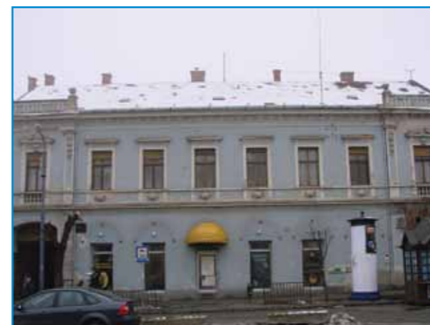
Keszthely, Fő tér - utcai homlokzat felújítás előtt
