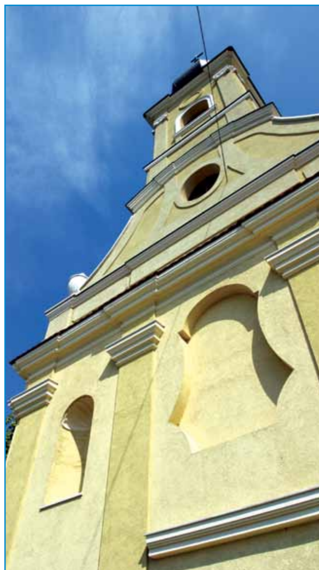
Pécs, Rácvárosi Római kat. templom - Főhomlokzat felújítás után
