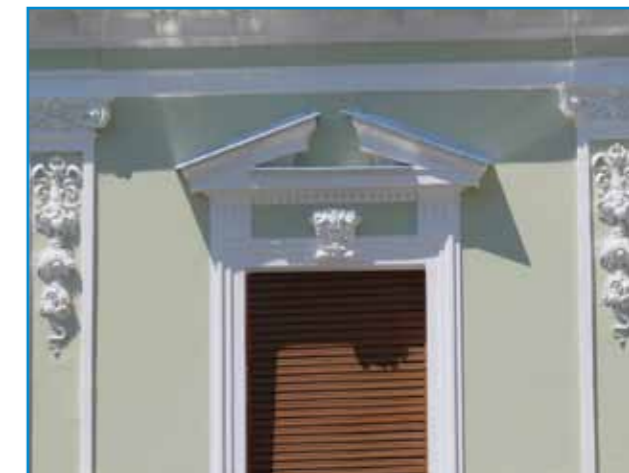
Keszthely, Fő tér - nyitott timpanonos ablakkeretezés felújítás után
