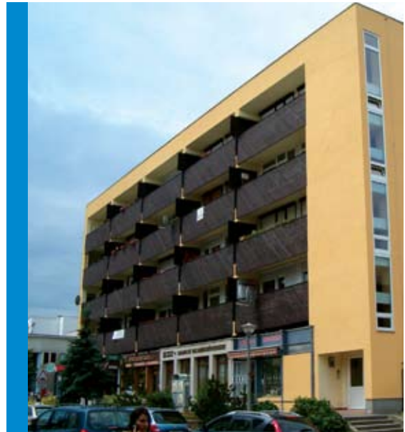
Panel felújítás - Mátészalka, Bajcsy u. 30.
