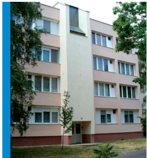
Panel felújítás - Mátészalka, Szokolay u. 12-14.
