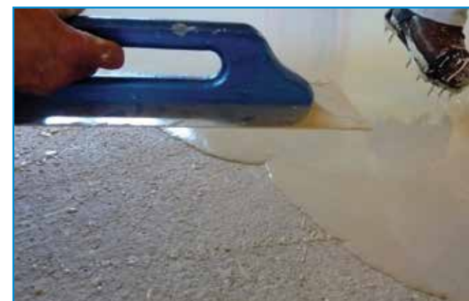
Szükség esetén a felületet kőműveskanállal vagy glettvasal kiigazíthatjuk.
