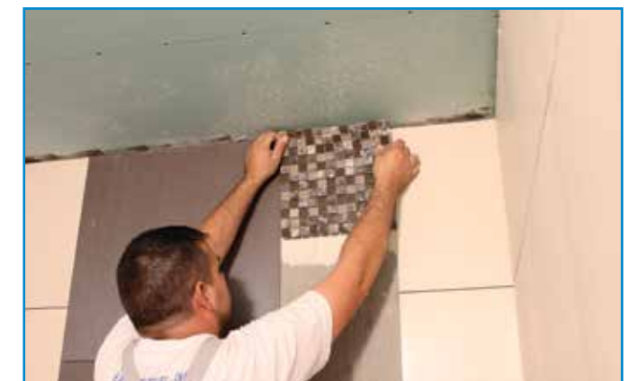
Burkolatváltásnál eltérő lapvastagság esetén a megfelelő fogadósínek kialakítását előzetesen kell elvégezni.
