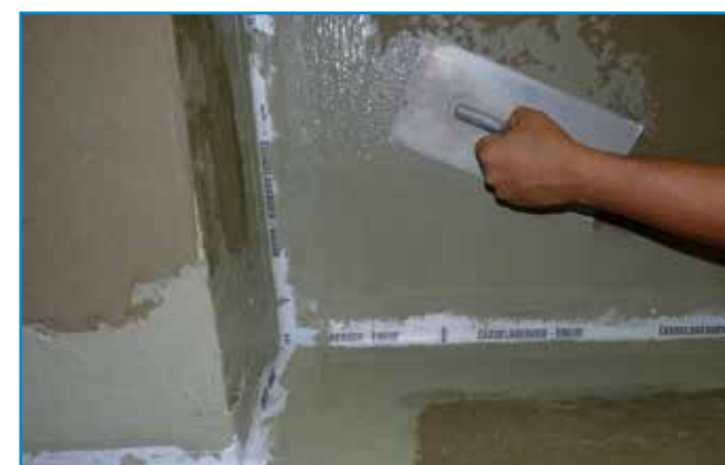
A hajlaterősítés beágyazása után a teljes felületre felhordjuk a második réteg vízszigetelést.
