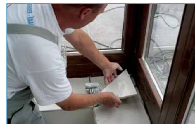
Fehér lapoknál célszerű fehér flexibilis ragasztó (Flex W) használatát.
