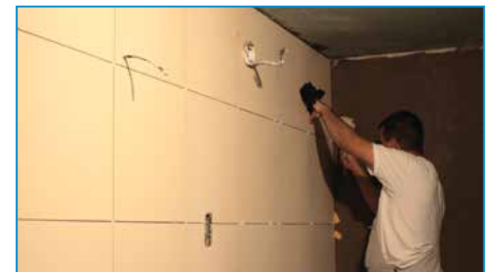
Nehéz, nagyméretű lapok ragasztása is egyszerűen, lecsúszásmentesen megoldható.
