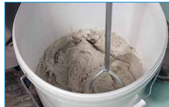
A fugázóanyagot a pontosan kimért komponensek hozzáadásával csomómentesre keverjük.
