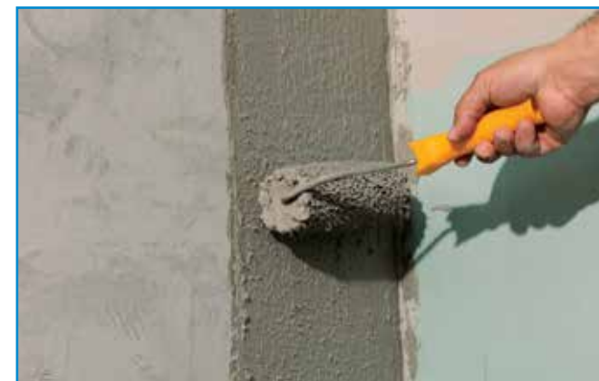
A kenhető szigetelés első rétegét a teljes felületre, sarkokba, élekre is kenjük fel.
