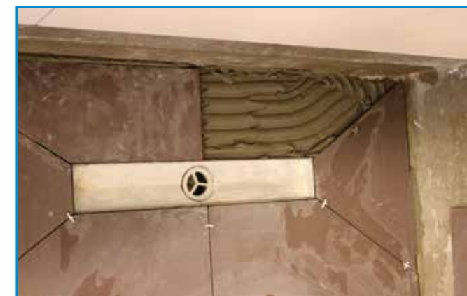
Fugakeresztek használatával biztosítható a lapok precíz illesztése.
