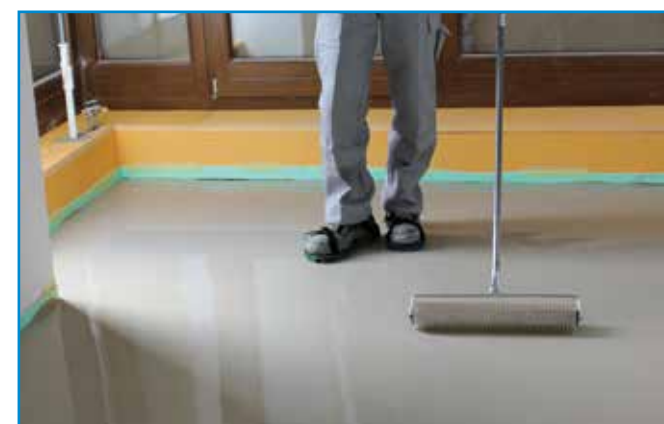
A frissen kiöntött aljzatkiegyenlítőt tuskéhengerrel kilevegőztetjük.
