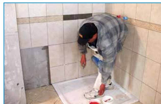
Beltérben Flex G ragasztót használunk a greslapok oldalfalon és aljzaton való elhelyezéséhez is!
