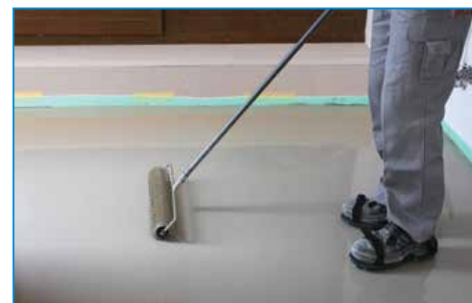
A gyorskötésű anyagoknál is fontos az önterülő aljzatkiegyenlítő kilevegőztetése.
