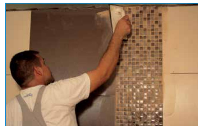
A fugázóanyagot speciális fugázó gumival juttatjuk a fugákba.
