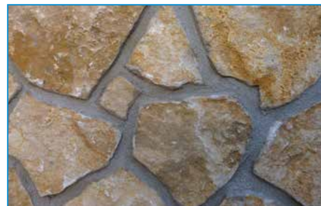
Amikor az anyag kellően meghúzott, ecsettel vagy kefével homogenizáljuk a fugák felületét. A köveket a fugázó teljes megköttése előtt tisztítsuk meg!
