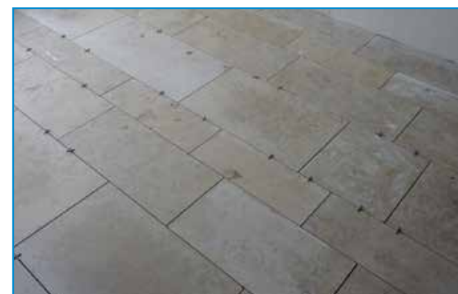
Az egyenletes, esztétikus burkolatkiosztást fugakeresztek használatával biztosítjuk.
