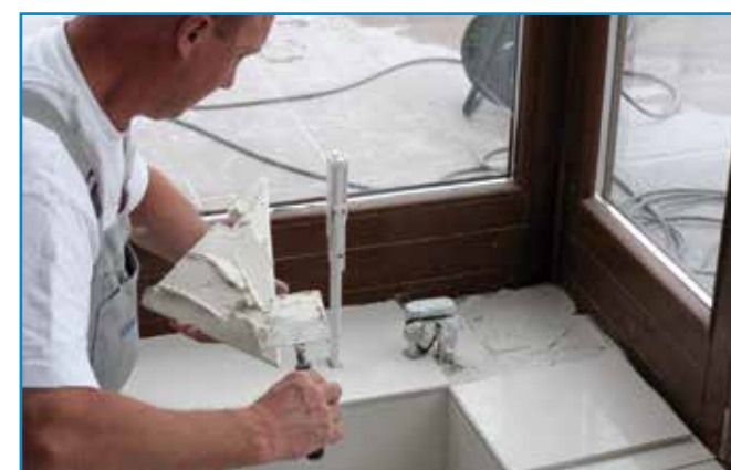
Fokozott hőmozgású helyeken a flexibilis ragasztót az alapfelületre és a burkolat hátoldalára egyaránt hordjuk fel.
