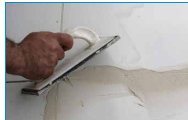
A fugázóanyagot a burkolólapok átlójának irányában hordjuk fel.
