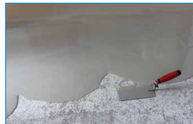
A munka megkezdésétől a felület kiegyenlítésének befejezéséig az anyagot folyamatosan keverjük be és hordjuk fel.
