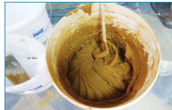
A fugázóanyagot a pontosan kimért víz hozzáadásával csomómentesre keverjük.
