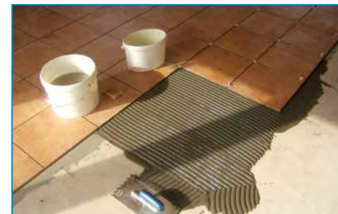
Kültérben és nagy forgalmú belső terekben ideális megoldás a gyorskötésű folyékonyágyazású ragasztó.
