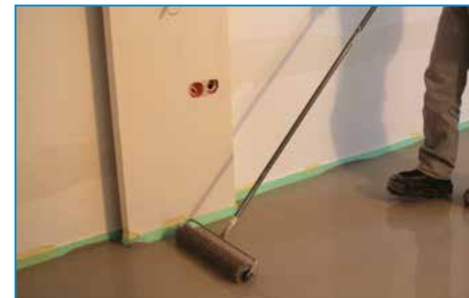
Tuskés hengerrel dolgozzuk át a frissen felhordott önterülő aljzatkiegyenlítőt.
