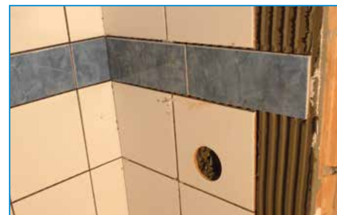
A csempevágás pontossága a sarkok kialakításakor a legszembetűnőbb.
