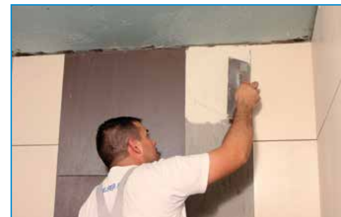
Az üvegmozaik ragasztó felhordását 3 mm-es glettvassal végezzük.
