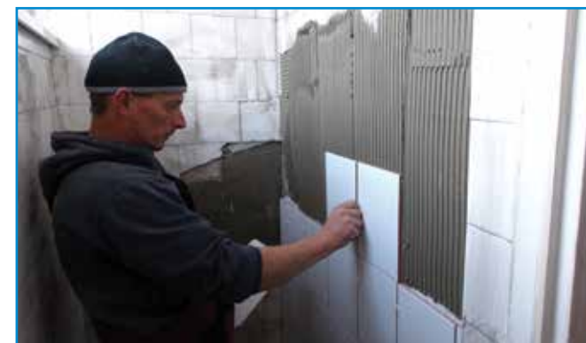
Kontakt B Plus alapozóval előkészített felületen kezdetük meg a lapra lap ragasztást.
