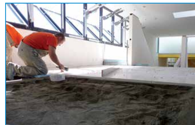
A burkolat elhelyezése előtt az előre előkészített, tömörített ágyat cementtejjel locsoljuk meg.
