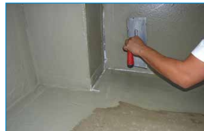
A kenhető szigetelést mindig legalább két rétegben hordjuk fel!
