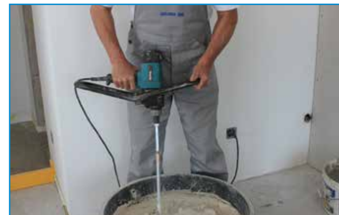
Az aljzatkiegyenlítőt lassú fordulatszámon működtetett keverőgéppel keverjük ki.
