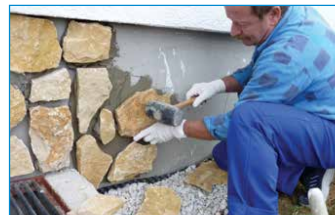
Ügyeljünk arra, hogy a burkolat és a fogadófelület közötti tér teljesen ki legyen töltve ragasztóhabarccsal.
