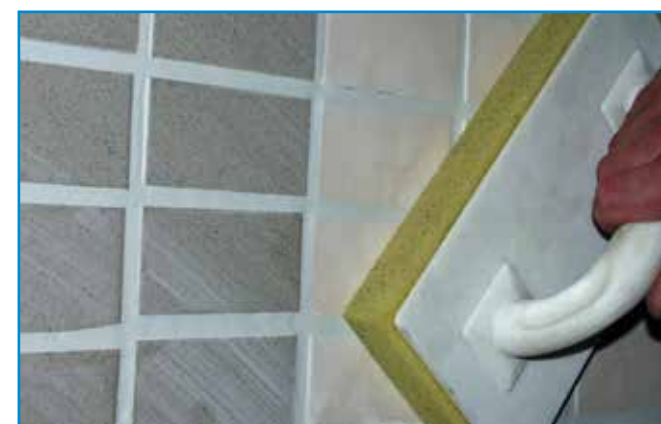
A lemosószivacsot enyhe nyomással húzzuk végig a felületen.
