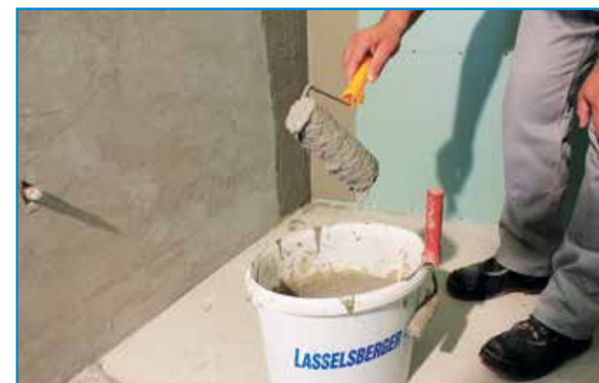
Hajlaterősítő szalag elhelyezésénél ügyeljünk arra, hogy a sarkoktól, élektől 1 cm távolságban kezdjük a vízszigetelő anyag felhordását!
