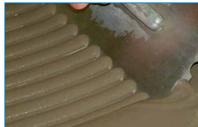
A Fliefflex ragasztóhoz a teljes térkitöltés érdekében speciális fogazott glettvast használjunk.
