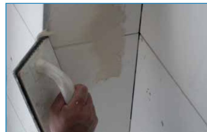
A csatlakozó profilok mentén is használjunk fugázóanyagot!
