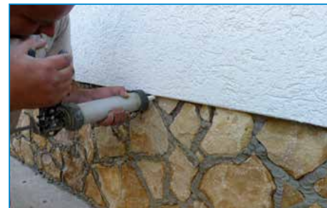
A fugázó anyagot fugázó kanállal vagy kinyomópisztollyal juttatjuk a helyére.
