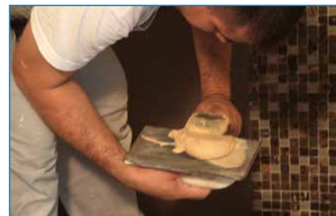
A fugázóanyagot speciális fugázó simítóval juttatjuk a fugákba.
