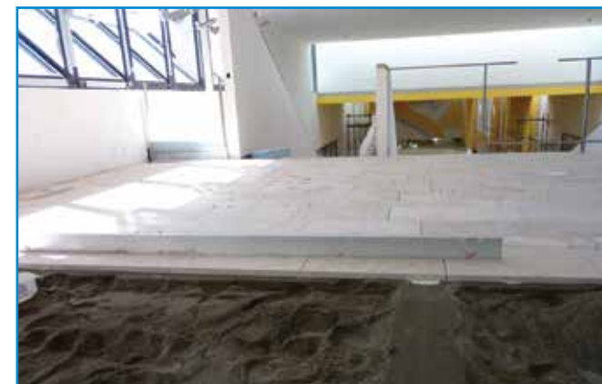
A vastag ágyazat lehetővé teszi a nem teljesen egyforma vastagságú burkolólapok, természetes kövek síkba fektetését.
