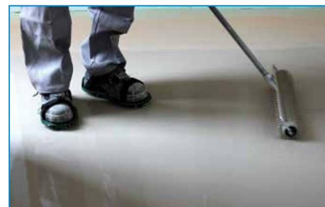
A rétegvastagságnak megfelelő tuskéhengert használjunk a kilevegőztetésre.
