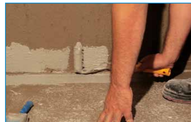
Az első réteg száradása után kezdetjük meg a hajlaterősítő szalag beágyazását.
