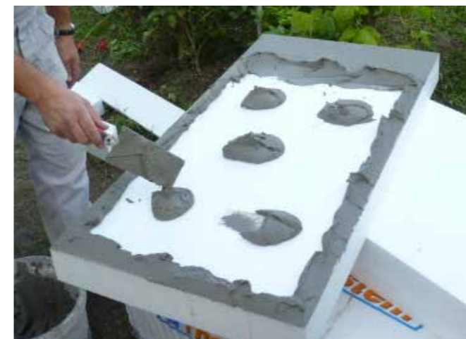
Rendszerragasztó kézi felhordása pont-perem módszerrel
