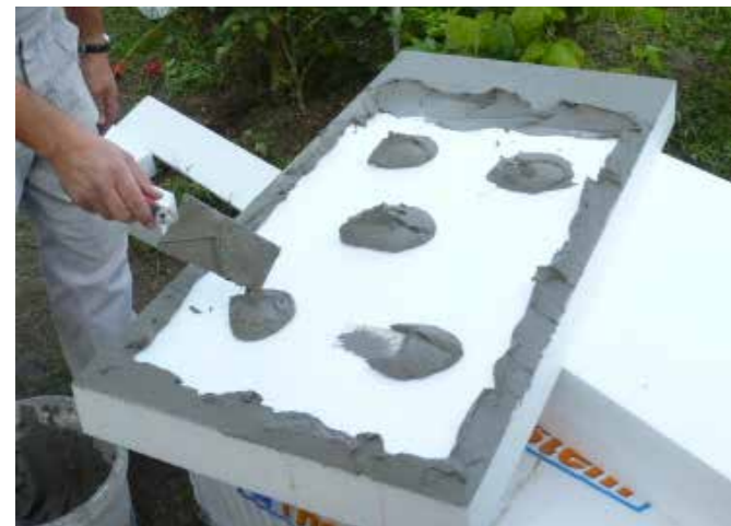
Rendszerragasztó kézi felhordása pont-perem módszerrel
