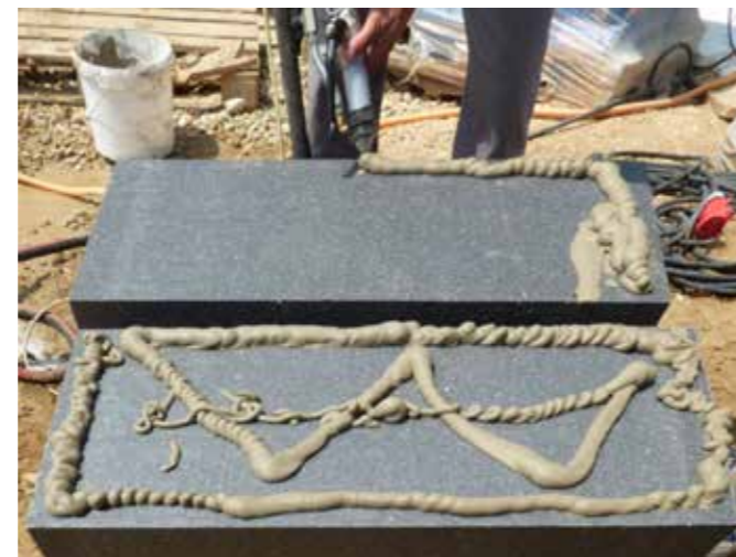
Rendszerragasztó gépi felhordása W-séma szerint
