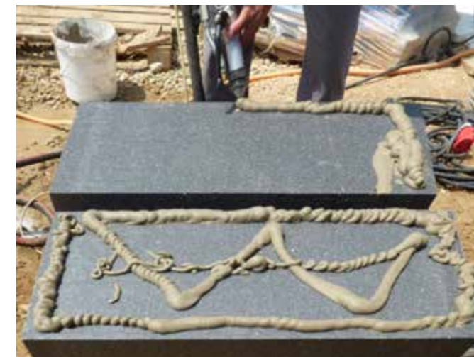
Rendszerragasztó gépi felhordása W-séma szerint
