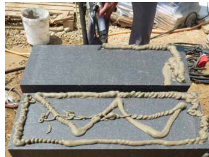
Rendszerragasztó gépi felhordása W-séma szerint
