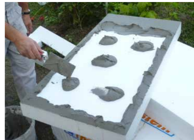
Rendszerragasztó kézi felhordása pont-perem módszerrel
