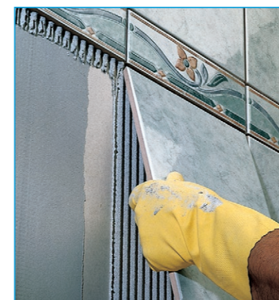
Burkolás egyoldalas kenéssel
