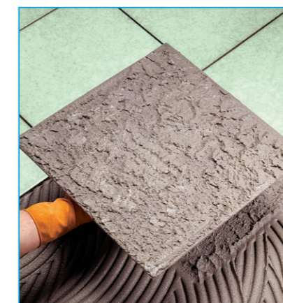
Burkolás kétoldalas kenéssel
