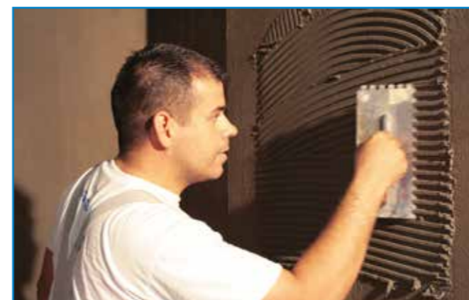
A szükséges ragasztómenyiség felhordását a glettvass fogméltségével és döntésével szabályozhatjuk.
